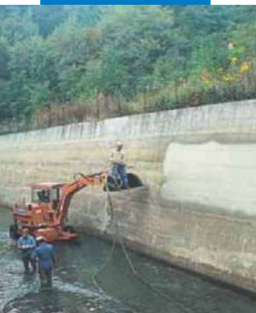
Thi công Idrosilex Pronto bằng súng phun ở kênh thủy điện
