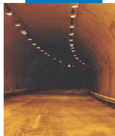
Thi công Idrosilex Pronto màu trắng bằng súng phun ở hầm đường cao tốc
