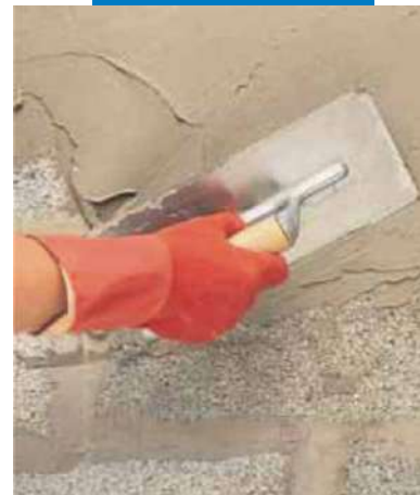
Thi công Idrosilex Pronto bằng bay
