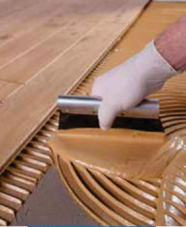
Tiến hành trải keo Ultrabond P990 1K
