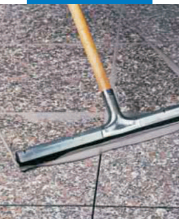
Chít mạch cho sàn bằng đá granite đánh bóng bằng bàn xoa cao su
