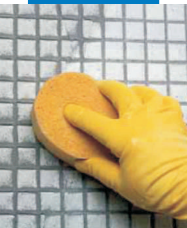
Hoàn thiện bề mặt mosaic thủy tinh bằng miếng bọt biển
