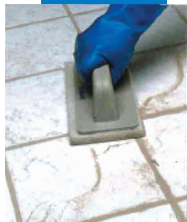
Hoàn thiện bằng miếng Scotch Brite®
