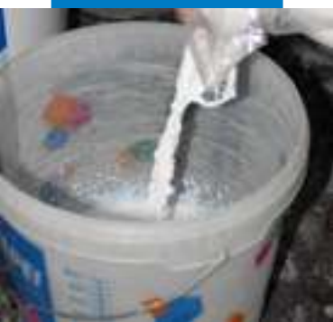
Cho thành phần B với lượng dùng tương ứng vào thùng trộn
